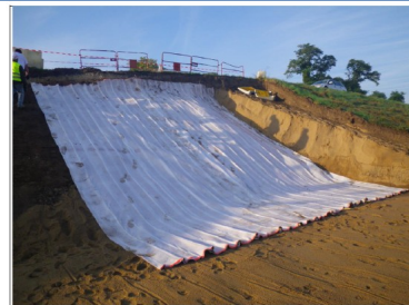
Figure 4 : Chantier de Bou-la-Binette, 2014. Détail du géocomposite de drainage - la partie visible (en blanc) correspond au filtre en contact avec la recharge. Les mini-drains améliorent la capacité de drainage dans le plan du géocomposite en association avec une dame drainante en géosynthétique. (Crédit photo DREAL Centre Val de Loire / DETL).
